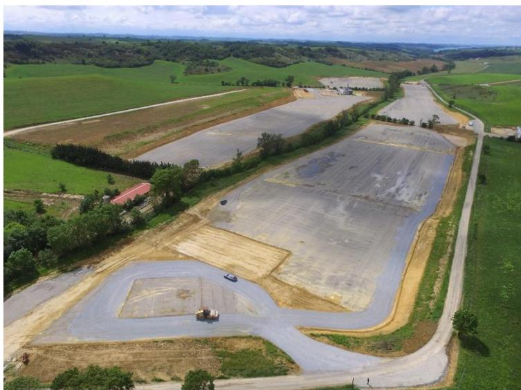
Vue du drone de Global EcoPower des quatre plateformes, terrassées sur 4,5 m de profondeur suite aux travaux archéologiques et finies au liant. Les quatre plateformes représentent une surface de 80 000 m<sup>2</sup> environ.
