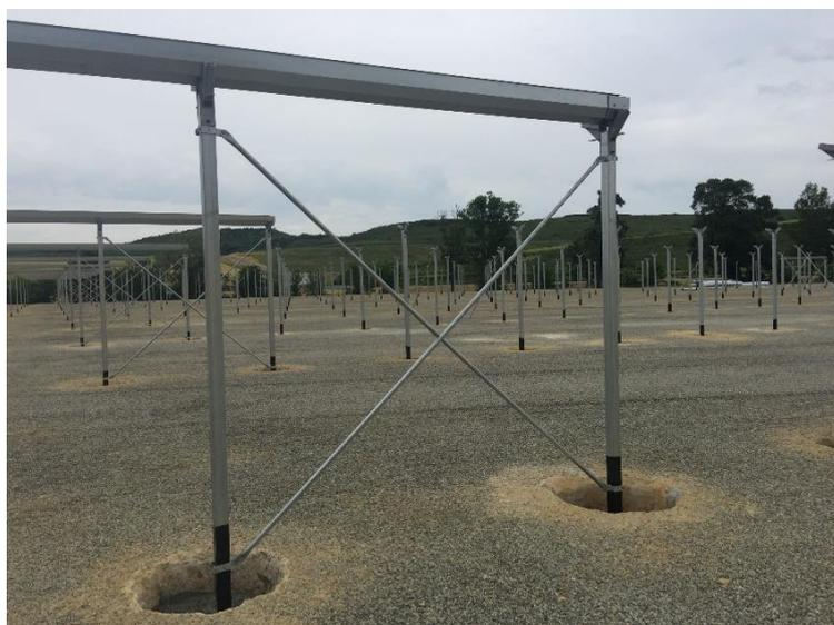
*Réalisation des fondations spéciales (CMC) sur parfois six mètres de profondeur, puis fondations et inclusions des platines devant recevoir les poteaux des serres.*
